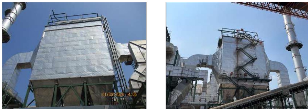
รูปที่ 2-3 ปล่องระบายอากาศและระบบบำบัดมลพิษทางอากาศแบบมัลติไซโคลน (Multicyclone) ต่ออนุกรม กับระบบบำบัดฝุ่นแบบไฟฟ้าสถิต (Electrostatic Precipitator : ESP)
