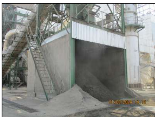
รูปที่ 2-21 อุปกรณ์ครอบกันการฟุ้งกระจายของเถ้าจากไซโล
