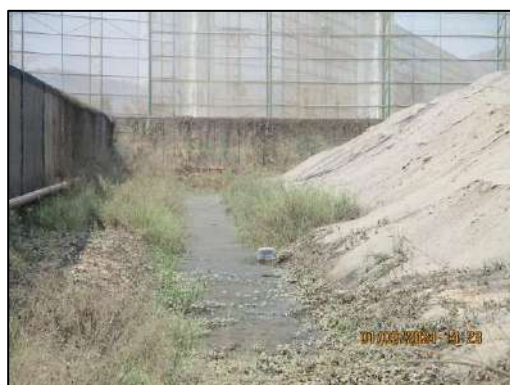
รูปที่ 2-13 รางระบายน้ำโดยรอบบริเวณลานกองเถ้า
