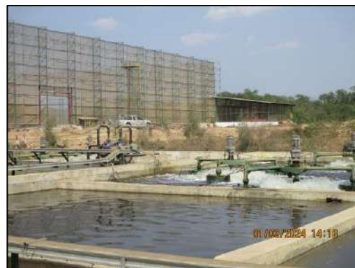
รูปที่ 2-33 ระบบบำบัดน้ำเสียแบบบ่อปรับเสถียร
