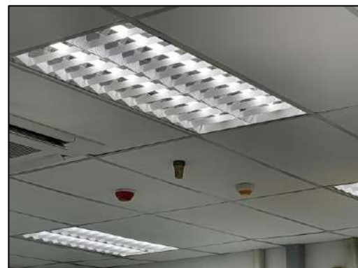
รูปที่ 2-43 ระบบตรวจสอบ ตรวจจับ สัญญาณเตือนภัยและอุปกรณ์ดับเพลิง
