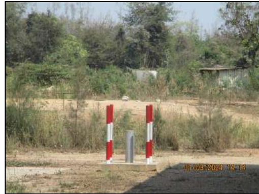
รูปที่ 2-36 บ่อสังเกตการณ์บริเวณระบบบำบัดน้ำเสีย
