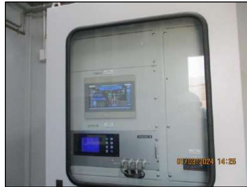
รูปที่ 2-5 หน้าจอแสดงผลตรวจวัดก๊าซคาร์บอนมอนอกไซด์และก๊าซออกซิเจนภายในหม้อไอน้ำ
