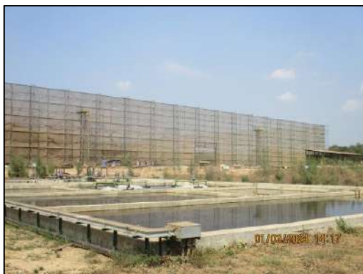
รูปที่ 2-33 ระบบบำบัดน้ำเสียแบบบ่อปรับเสถียร
