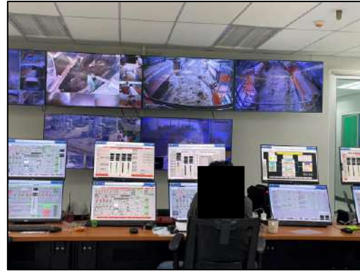
รูปที่ 2-8 พนักงานควบคุมระบบสายพานลำเลียงเชื้อเพลิง
